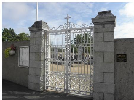
Pour consolider l'ensemble sur les piliers, les fixations, les gongs et les pivots ont été renforcés par un cerclage métallique afin de supporter la charge très lourde de chaque vantail.
